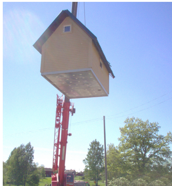
Fig 4 Värmestugan Agda lyfts på plats
