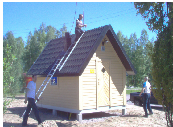
Fig 5 Värmestugan Agda placerad på plintar
